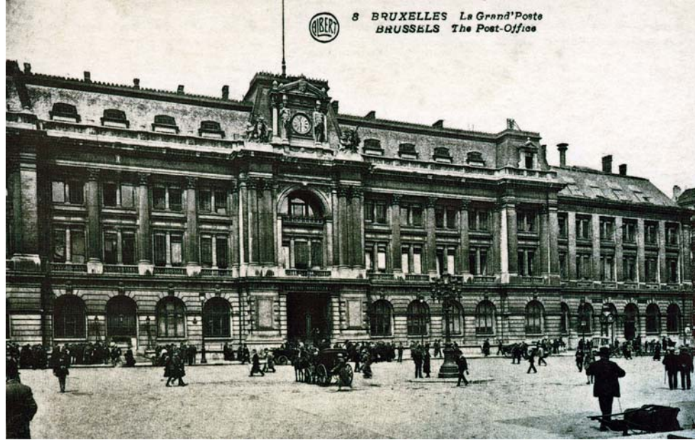
1900-1966 Tarihleri Arasında Kullanılan Belçika Brüksel Büyük Posta Binası
